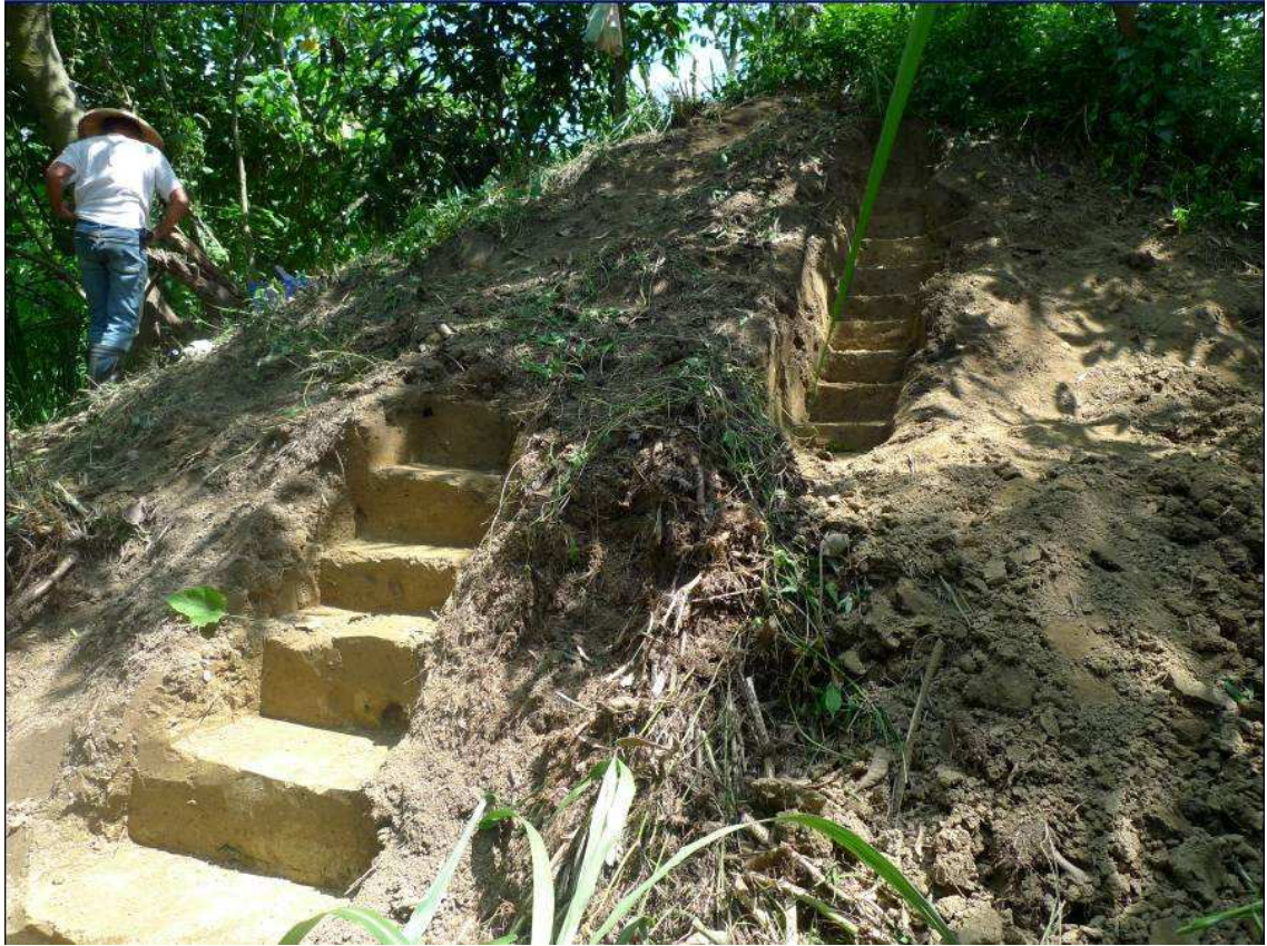
圖版 19：八甲橋西側河流轉彎高處露頭以坭土層為主（標高約 18.2~22.3m）
