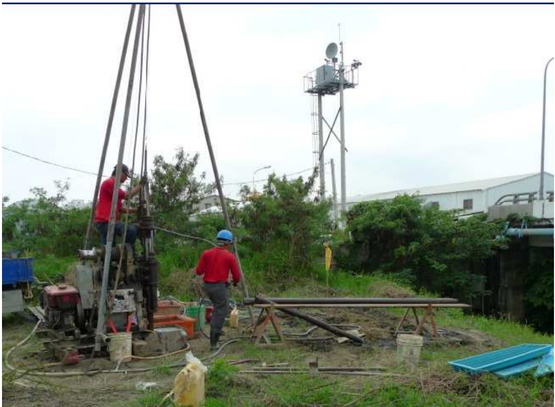
圖版 10：HQ 岩心取樣現場工作狀況
