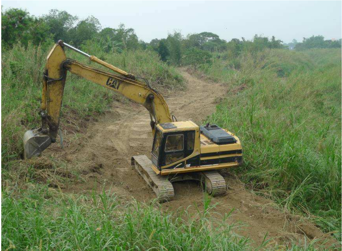
圖版 7：施工前以挖土機進行整地作業
